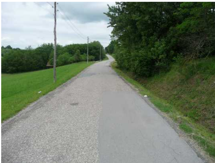
Slika 5.8. Lokalna cesta L37050 (Prnjarovec)
